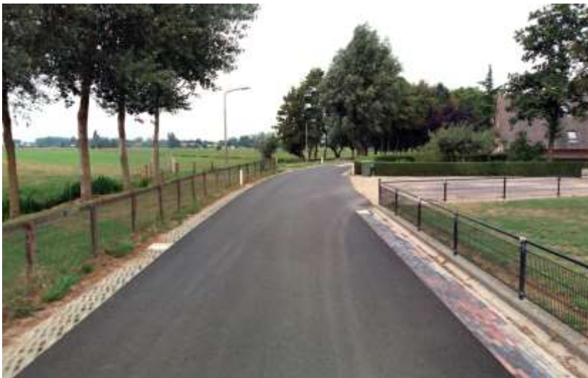
Foto project Weverwijk: voorbeeld van een optische wegversmalling met grasbetontegels (links) en klinkers (rechts) langs de zijkanen van de weg.
