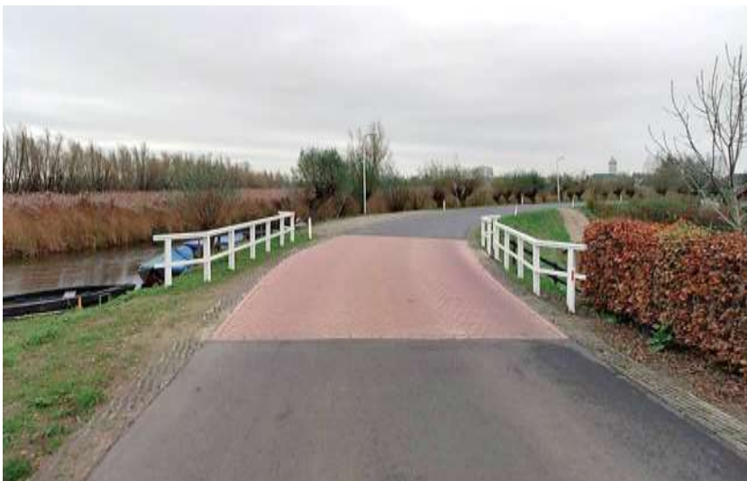
Foto project Zouwendijk: voorbeeld snelheidsremmer (een heultje) met hekje en lange flauwe helling uitgevoerd in klinkers. Vooral het visuele effect zorgt voor vermindering van de snelheid.
