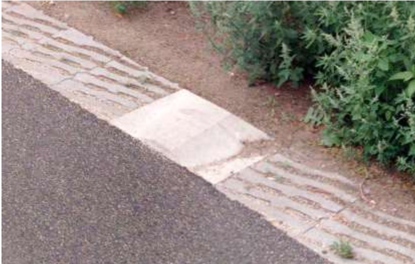
Foto: voorbeeld van een bermtegel met een schuin opstaand randje in grasbetontegels met een golvend patroon
