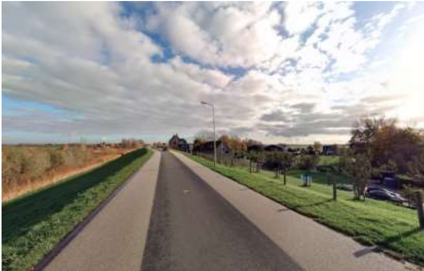
Foto project Lekdijk: het verschil tussen asfalt met een lichte kleur en meer gangbaar “zwart” asfalt is op bovenstaande foto goed te zien. Bij de Grotewaard wordt het middendeel smaller en voorzien van een antraciet coating.
