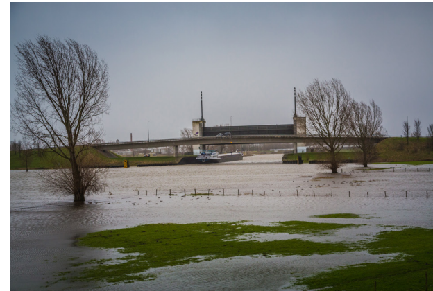
Figuur 12b: De Keersluis in Wijk en Aalburg die gesloten kan worden als het water in de afgedamde Maas te hoog wordt (A)
