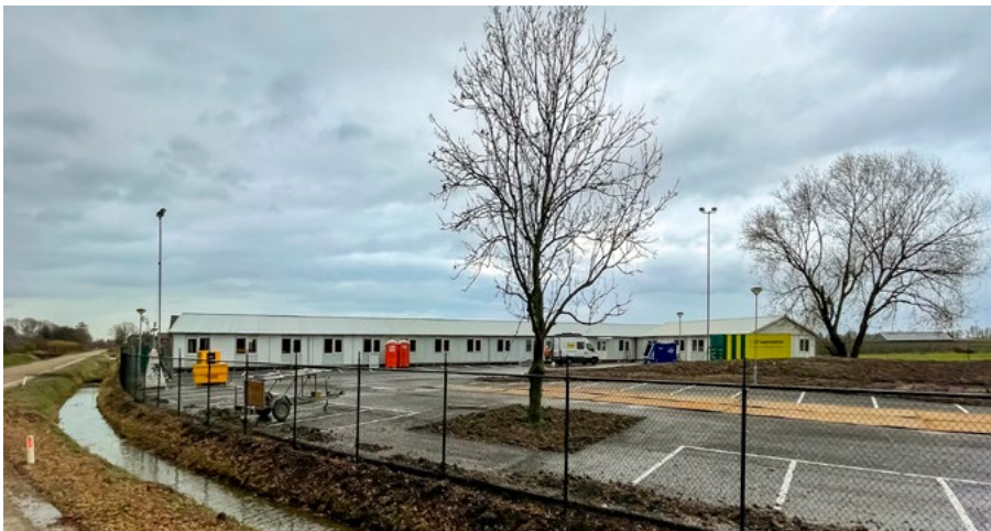
Bouwcombinatie Mekante Diek bouwt een projectkantoor aan de Weiweg in Varik. Mekante Diek verwacht begin 2022 vanaf deze locatie te gaan werken. De medewerkers parkeren op het terrein van het projectkantoor.
