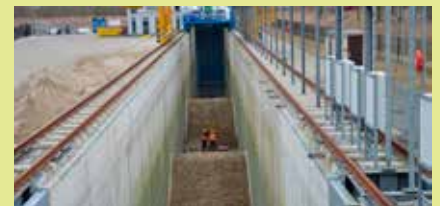
Opbouw voor de Grofzand Barrière.
