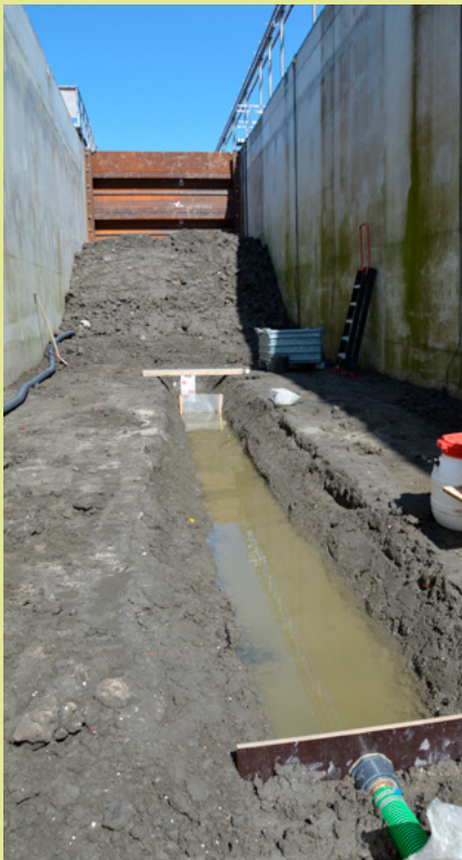
Opbouw grofzandbarrière in de Deltagoot.
