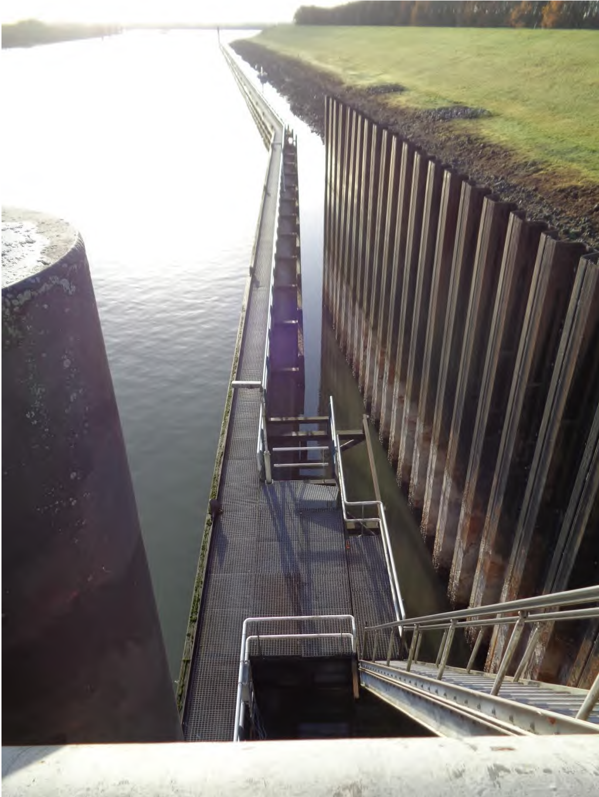
Foto T&A: sluis
