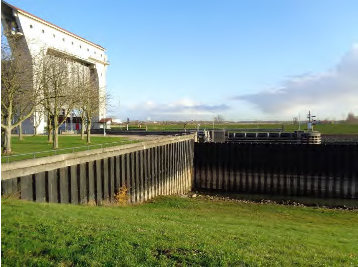
Foto T&A: sluis
