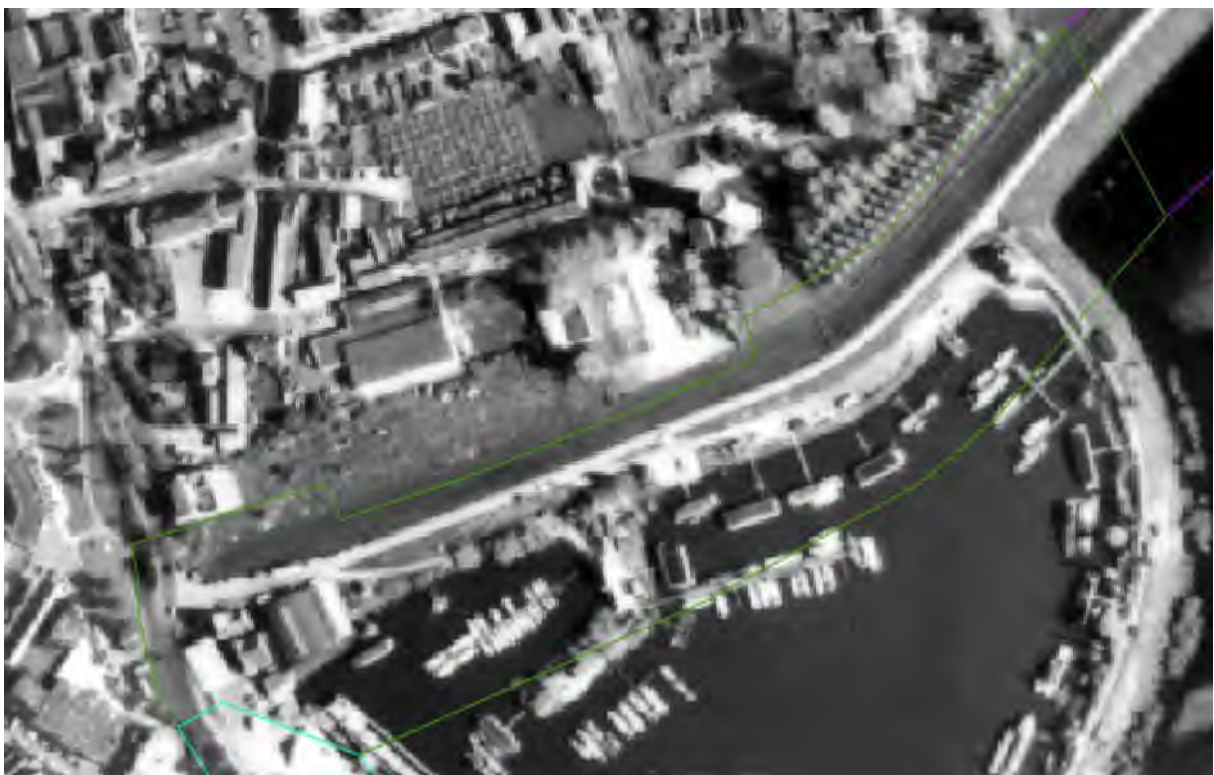
Situatie 1989 via www.dotkadata.nl . Behalve een nieuwe afrit richting haven en de plaatselijke verbreding van wegverharding worden er geen grote wijzigingen waargenomen.
