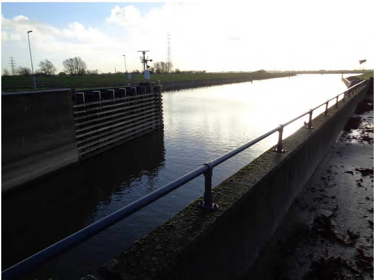
Foto T&A: sluis
