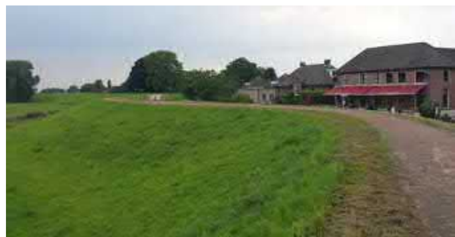
Bij Ophemert is aan binnendijkse zijde sprake van een tuimeldijk (dp 062-066) met daarop de doorgaande weg. Op de kruin ligt een fietspad. Het buitendijkse talud is 1:3. Ten zuiden van de dorpskern is het binnendijkse talud 1:3, buitendijks is het steile talud behouden, maar aangevuld met een laag, smal bermpje.
