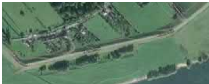
De meeste afritten langs deze dijk dalen logisch mee in het dijktalud en zijn daardoor ondergeschikt aan de hoofdvorm van de dijk
