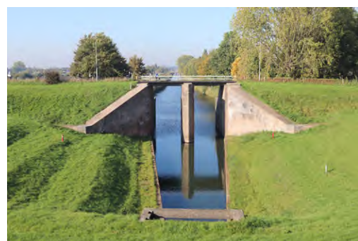
De sluis met doorkijk op het inundatiekanaal
