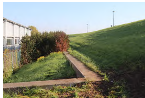
Taludverkorting met damwand bij Aldi-terrein
