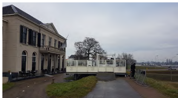
Positie van het fietspad tussen terras en restaurant Bellevue
