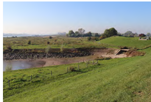
Niet functionerende doorlaat in de dijk
