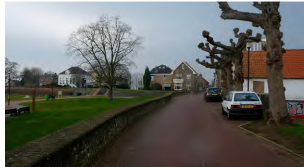
Oude vestingmuur (rijksmonument)
