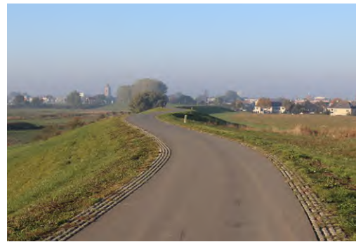
Groene kering. Asfalt met uitloopstrook van betonklinkers. Weinig dijkafgangen.
