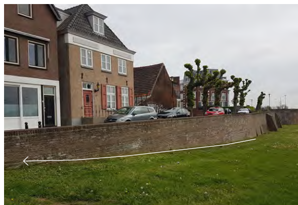
Foto van het oplopend talud langs de stadmuur, in de hoek bij de aansluiting op de waterkering richting Bellevue
