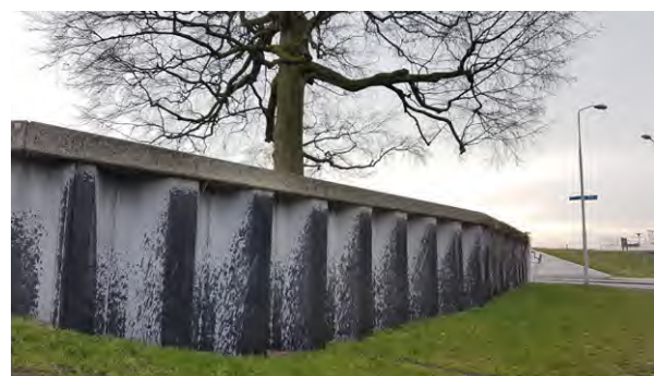
Onafgewerkte zichtbare damwand bij de monumentale beuk
