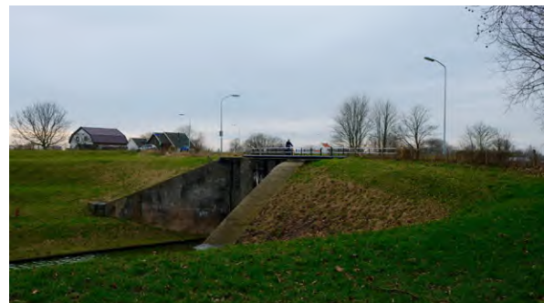
Historische inundatiesluis, onderdeel waterlinie
