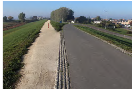
Oprit naar fietspad op de tuimelkade
