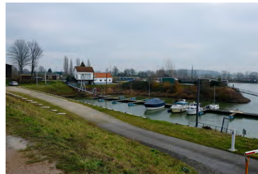
Afrit met parkeren achter slagboom
