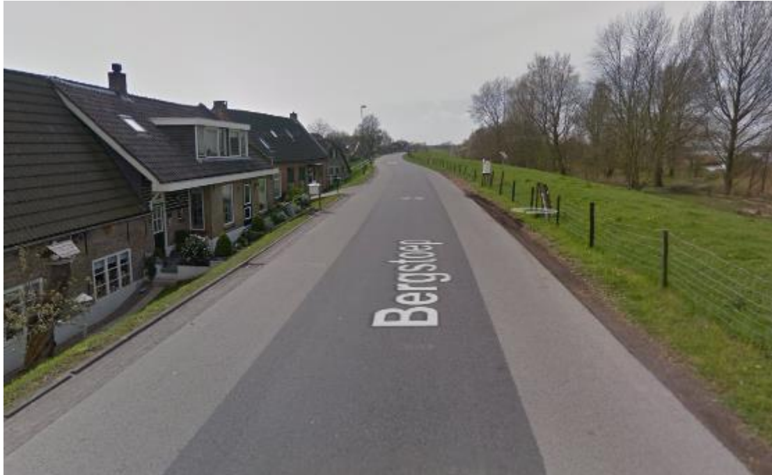
Figuur 11-1 Woningen langs dijkvak 85 met de te verhogen tuimelkade rechts in beeld - Foto afkomstig van Google Streetview.
